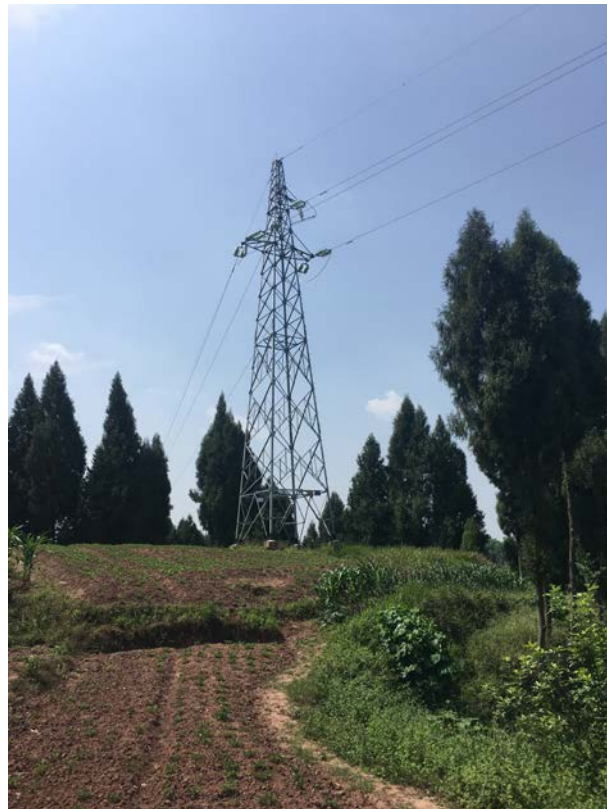
渠县琅琊至鲜渡 35kv 线路工程新建塔基 41 基（其中单回路直线塔 20 基，单回路耐张塔 21 基）
