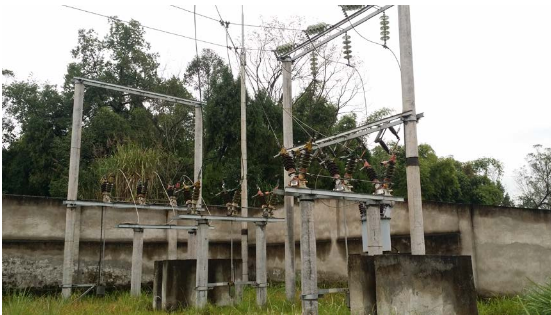
项目起点 110kV 琅琊变电站 35kV 出线间隔
