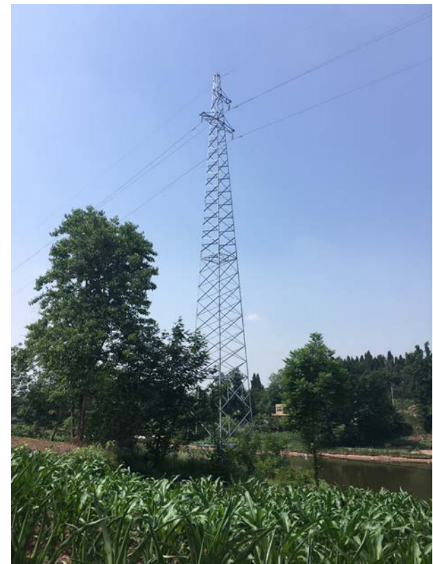
渠县琅琊至鲜渡 35kv 线路工程新建塔基 41 基（其中单回路直线塔 20 基，单回路耐张塔 21 基）
